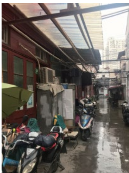
Figure 2 : L'état actuel de la ruelle YF avant la rénovation
