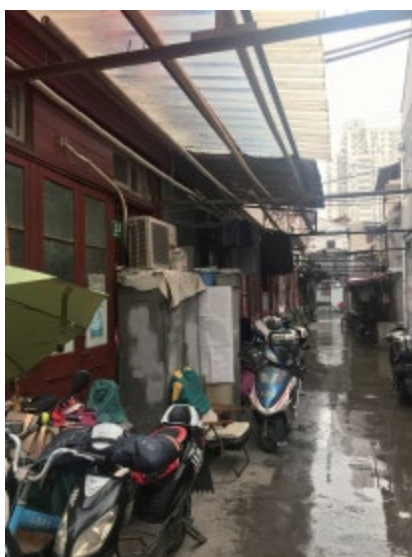
Рисунок 2. Текущее состояние района YF до реконструкции.
