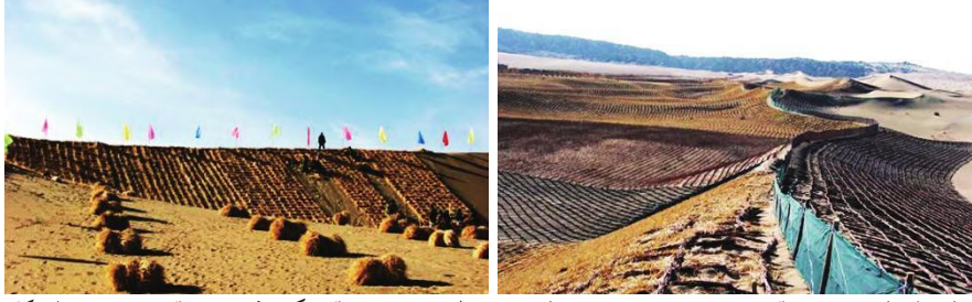
والرمال الرياح حماية مشروع - هوانغ دونغ في منها والاستفادة موقا كهوف حماية مشروع 4 الشكل والرمال الرياح حماية مشروع :هوانغ دونغ في واستغلالها موقا كهوف على الحفاظ مشروع 4 الشكل دونغ لمدينة الإقليمية المكانية الرئيسية الخطة . (بكين) الصينية التخطيط لأكاديمية التابعة والتصميم التخطيط شركة :المصدر 2020-2023 ، ③ المشروع فريق ( 2021-2035 ) هوانغ
